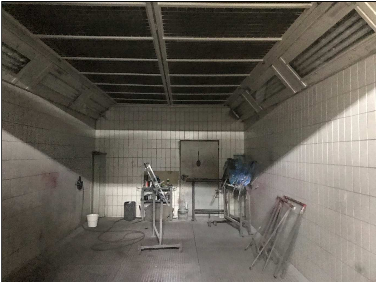
Abbildung 9 Blick in den Lackierraum (g)
