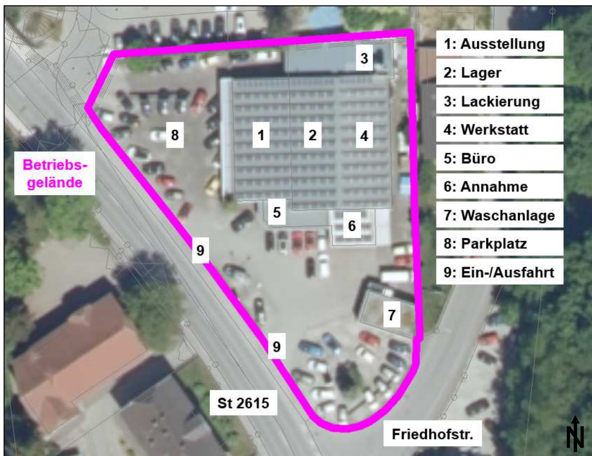
Abbildung 7 Digitales Orthofoto (c) mit Darstellung des Betriebsgeländes
